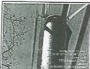
No hay aplicación de grout entre placa y columna.
