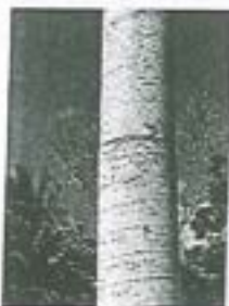
Se observa detalle en junta fría de ambos colados.
