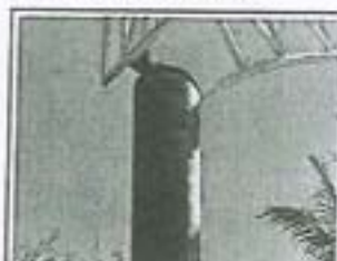
Las placas no se observan entrecruzados como se requiere. Se requieren con un diámetro mayor al de las columnas.
