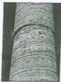
Se observa mala alineación de cimbra en segundo colado.
