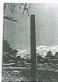
Se observa descostillamiento en parte superior de columna y superficie de columna marcada por cimbra.
